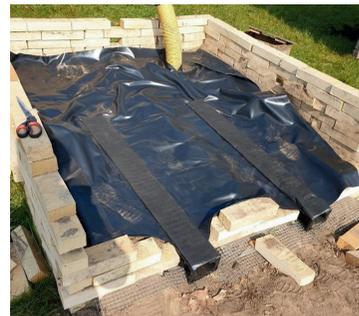
Abbildung 1. Querschnitt des Hochbeetes mit Teichfolie und Vliesbedeckten Entwässerungsrinnen.
